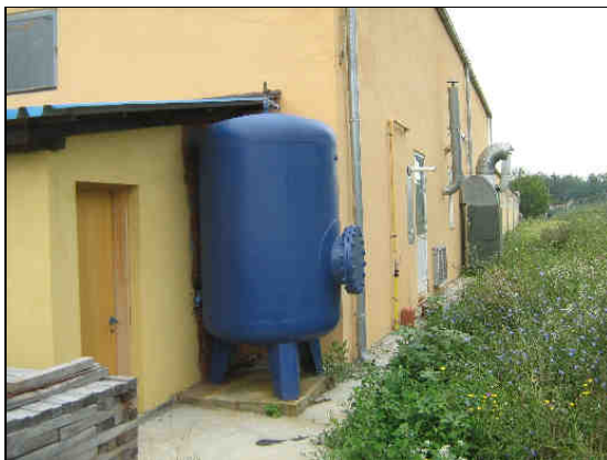
Rezervoar za vazduh i rezervoar za TNG
