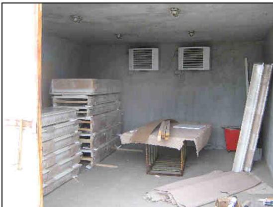
Komora za sušenje građe
