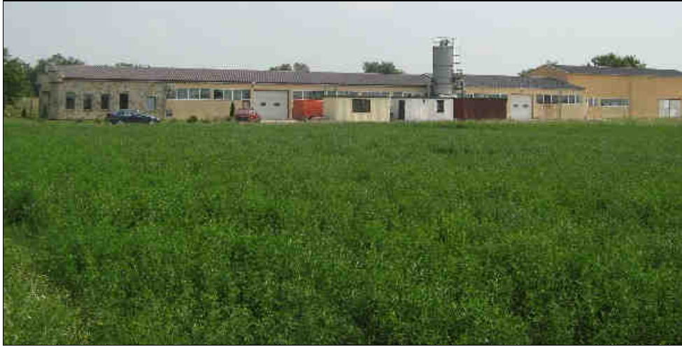
Poslovno proizvodni objekat
