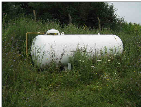
Rezervoar za vazduh i rezervoar za TNG
