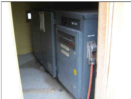
Vijčani kompresor ATLAS COPCO GA210
